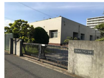
高洲第2ポンプ場 昭和48年10月運用開始
