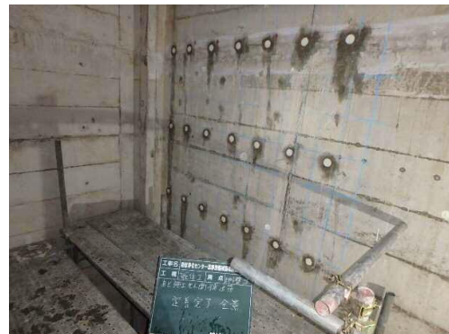
耐震補強工事（補強筋施工）
