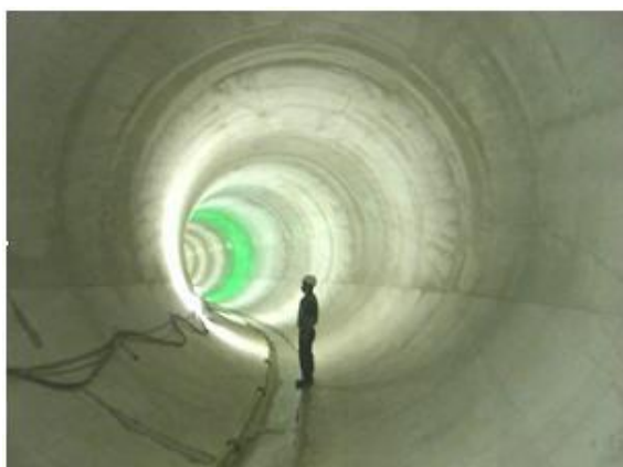
中央雨水 1 号貯留幹線
