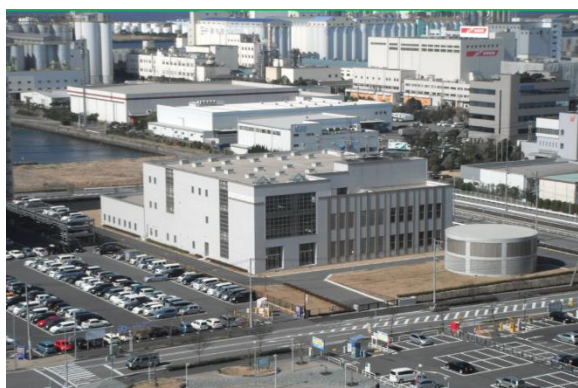
中央雨水ポンプ場
