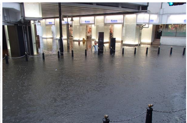
JR千葉駅前の浸水状況
