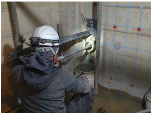
耐震補強工事（補強筋施工）
