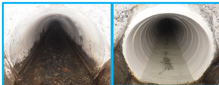
管きよの改築
