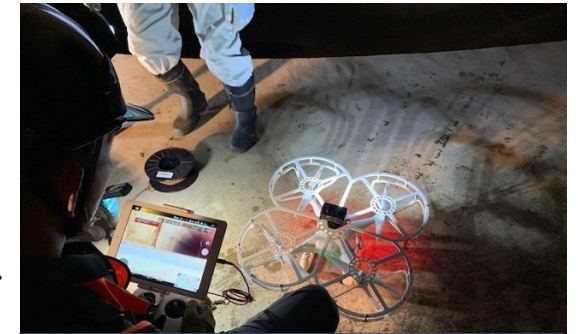
ドローンによる管内調査
