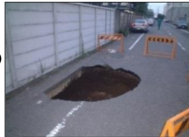
道路陥没状況
