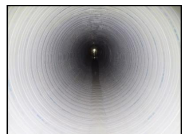
改築後(管更生)
