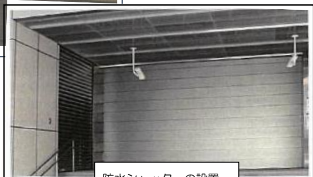
防水シャッターの設置
