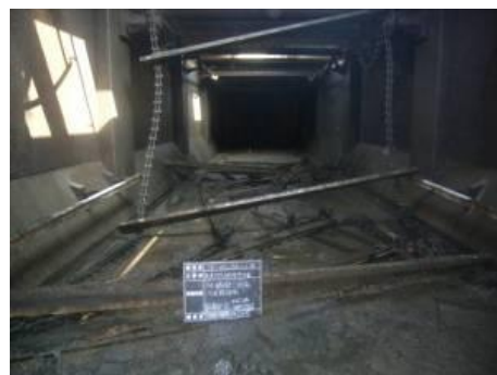
【汚泥掻寄機の復旧】
