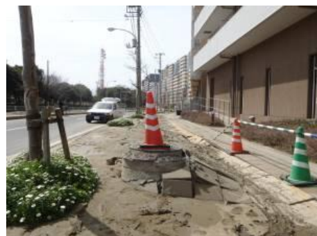
【マンホール浮上の復旧】
