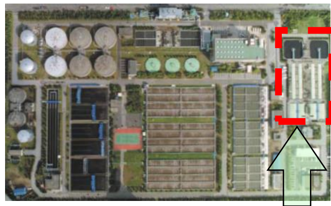
水処理施設から雨水滞水池として活用
