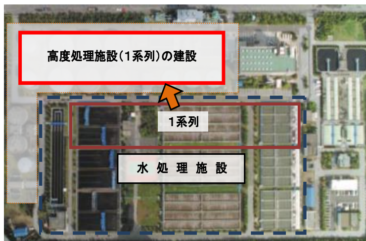
（中央浄化センター）
