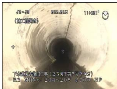
【管渠ひび割れの復旧】
