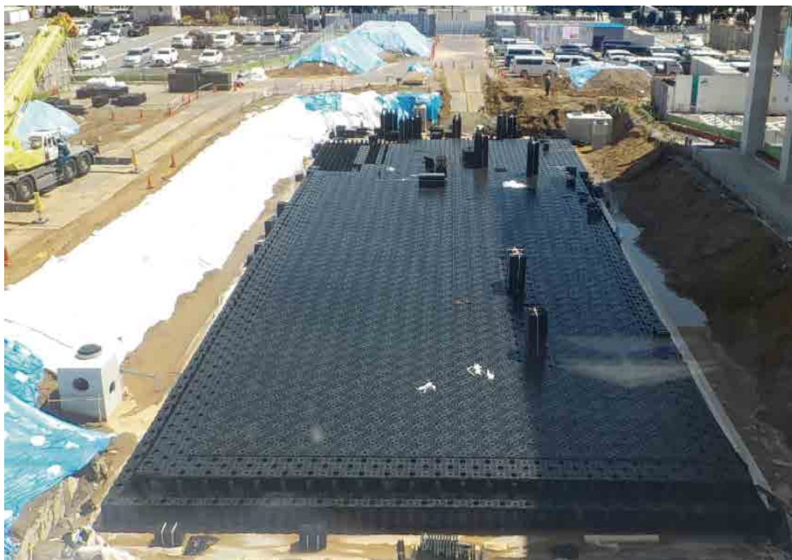
プラスチック製雨水抑制施設 (ユニット組立施工状況写真)
