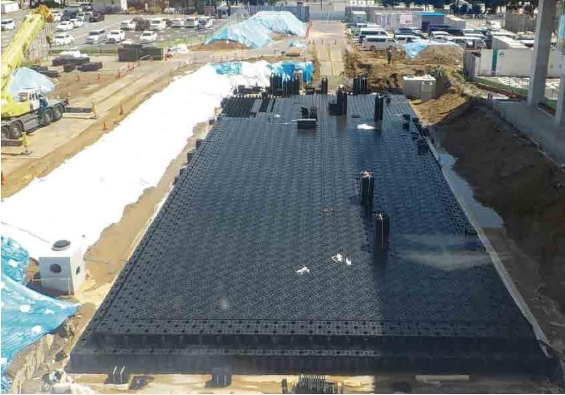
プラスチック製雨水抑制施設
