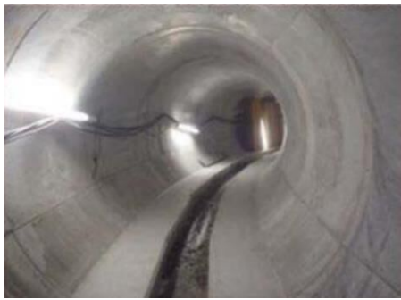
写真2 丸子その1雨水幹線（管内）
