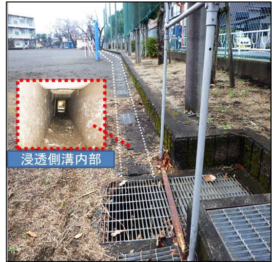
校庭貯留施設
