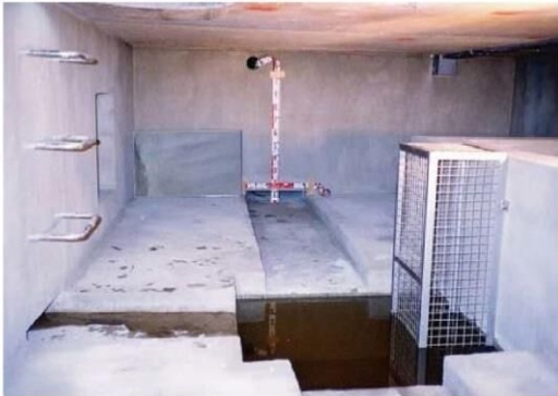
貯留施設（地下貯留）
