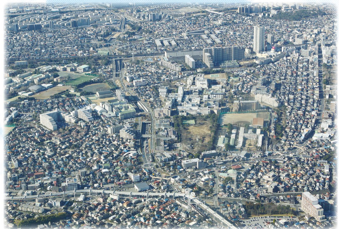
都市計画道路 新港横戸町線(平成24年2月 全線供用開始)
