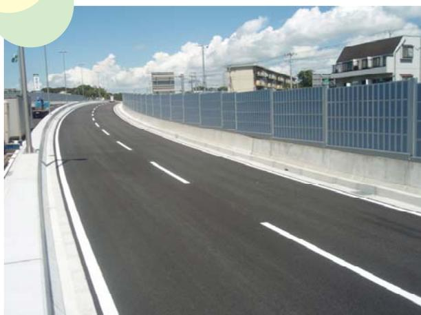
【遮音壁の設置例(黒砂陸橋上、高さ3m)】
