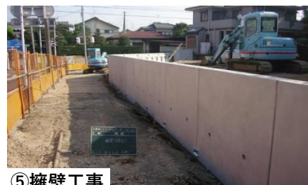
⑤擁壁工事
