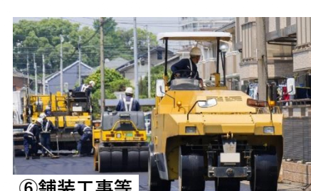
⑥舗装工事等
