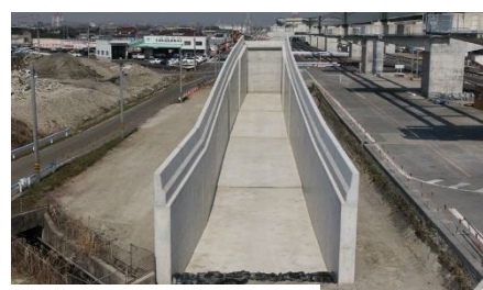
④スロープ部擁壁工事
