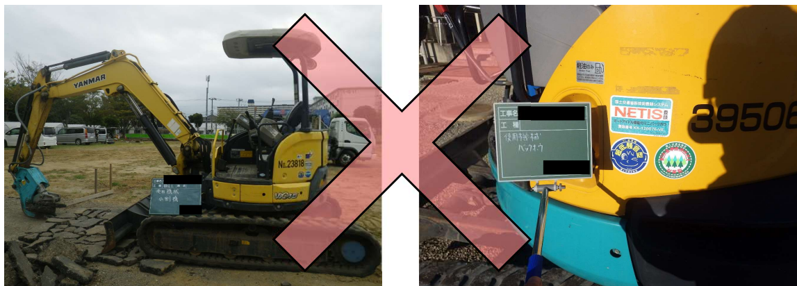
排ガス・低騒音機械確認写真
