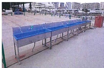
現場の手洗い場所の増設
