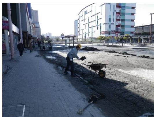
写真3－9 土砂撤去作業状況（海浜幕張駅駅前広場）
