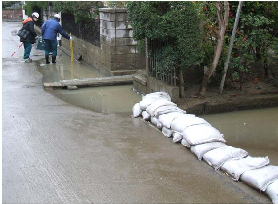
写真 3-1 排水の緊急対策
