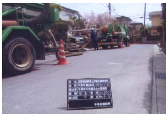
写真3-13 作業状況 (側溝内の土砂撤去)
