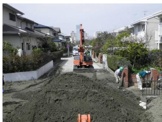
写真3－10 土砂撤去作業状況（美浜区磯辺7丁目）
