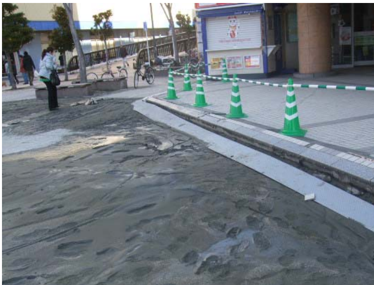
写真 6 - 3 3 検見川浜駅前広場
