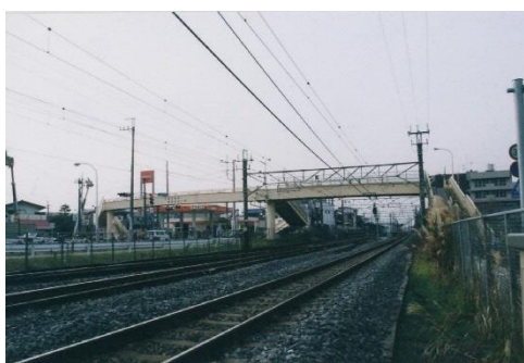
写真7 誉田歩道橋（跨線橋）
