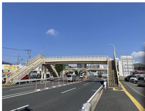
写真4 穴園第1歩道橋
