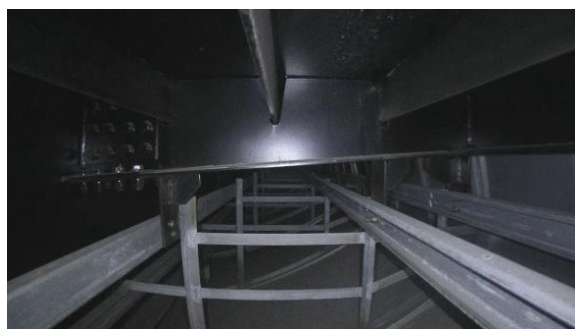
写真11 ドローンからの映像 （化粧パネル内部）
