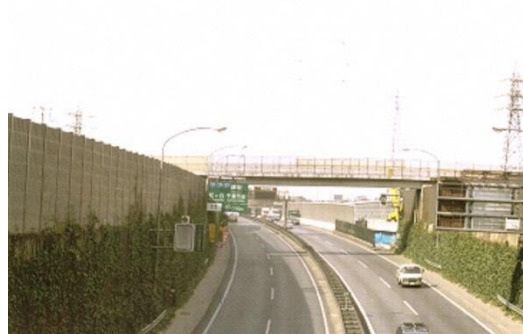
写真8 宮野木歩道橋（跨道橋）
