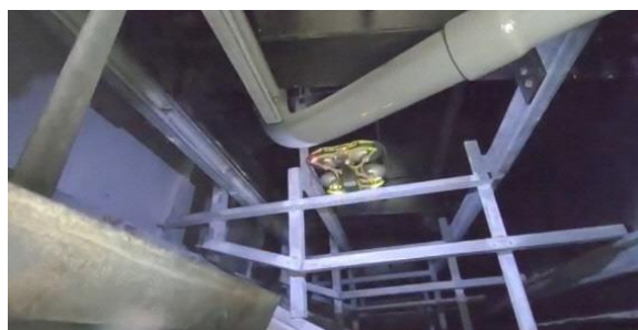
写真10 ドローンでの点検状況 （化粧パネル内部）
