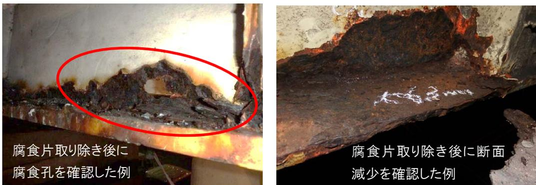
腐食片を取り除いた状態の例(主桁)
