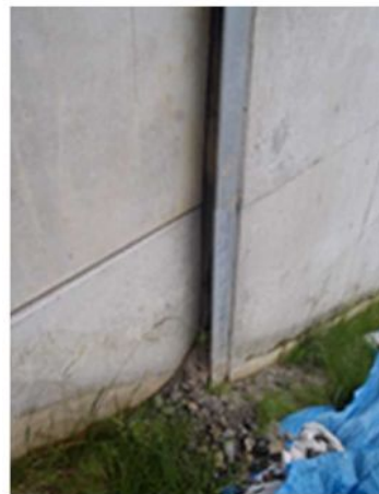
写真 4-3 土砂のこぼれ出し例
