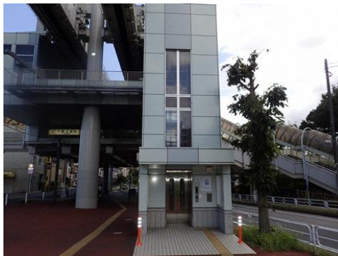
エレベーター
