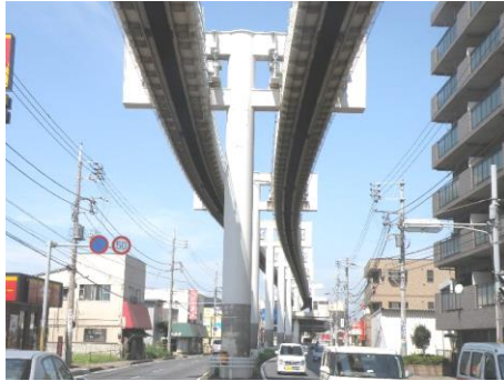
鋼支柱の外観（T型支柱）
