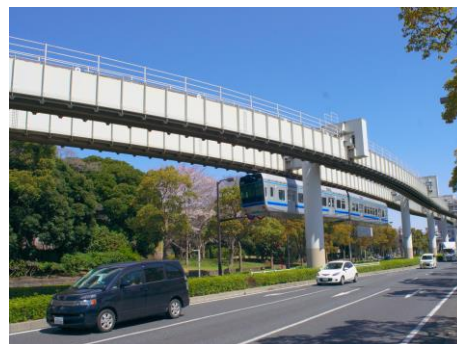
軌道桁の外観 2
