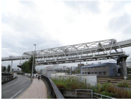
トラス橋の外観 2（総武線横断部）
