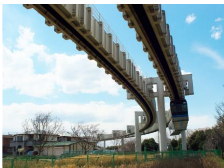
軌道桁の外観 1
