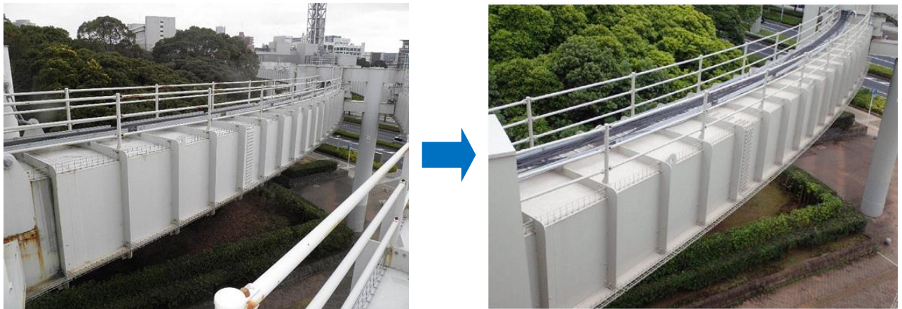
塗装塗替え（軌道桁）
