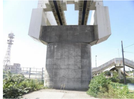
鉄筋コンクリート支柱の外観
