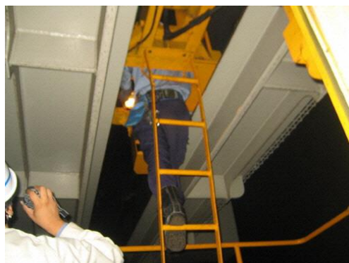
軌道作業車による点検
