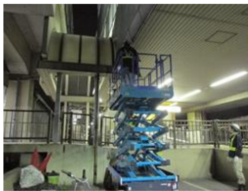
定期点検の作業状況(停留場)
