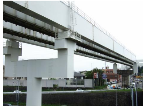
箱桁橋の外観（京葉道路横断部）
