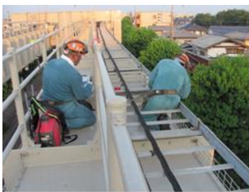
定期点検の作業状況(軌道桁)
