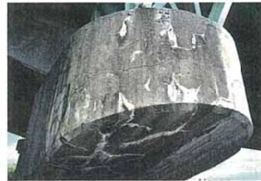
写真-5.31 橋脚の幅が大きいひびわれ(②)
