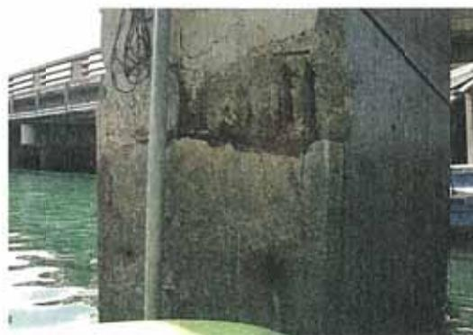
写真-6.12 橋脚の鉄筋露出
