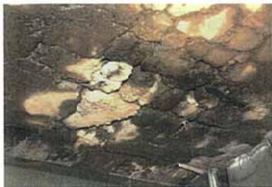
写真-7.1 格子状ひびわれ(角落ち・漏水)
