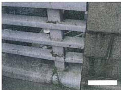
参考写真-4.5 遊間異常により高欄が損傷が生じた例
