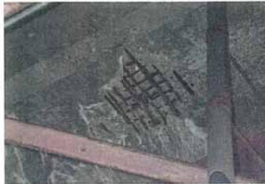
写真-7.2 床版の鉄筋露出
