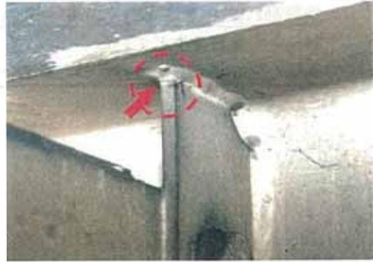
写真-2.2 垂直補剛材の塗膜割れ
