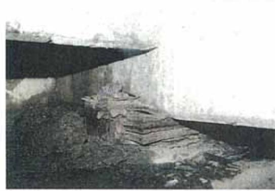
写真-11.11 支承本体の腐食
