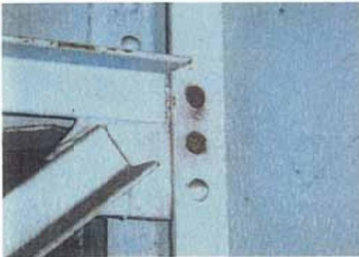
写真-3.8 対傾構のホルト脱落 (リベット)
