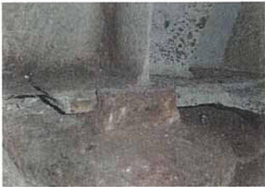
写真-2.6 主桁下フランジの亀裂
