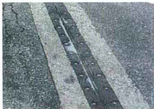
写真-10.5 伸縮継手部の段差
