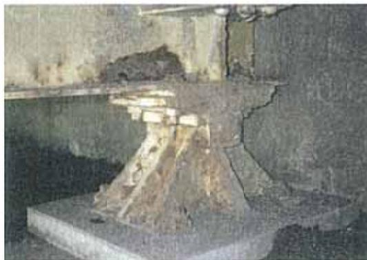
写真-11.12 支承本体の腐食
