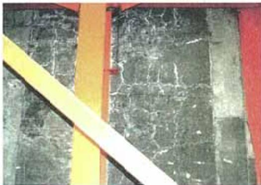
写真-8.25 格子状ひびわれ(角落ち・遊離石灰)
