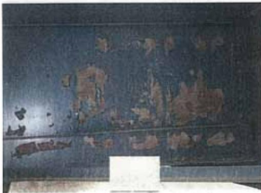
写真-1.10 主桁ウェブの発錆
