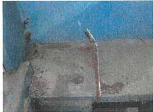
写真-2.7 主桁下フランジの亀裂
