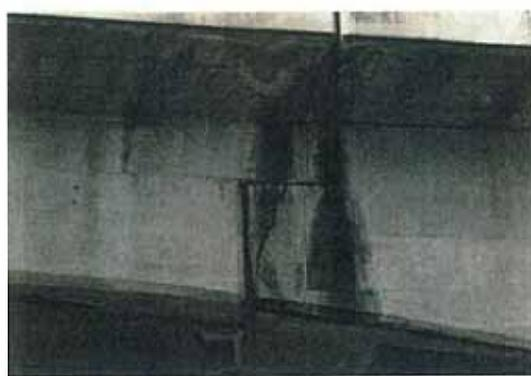
写真-5.18 主桁の幅が大きいひびわれ(⑦)
