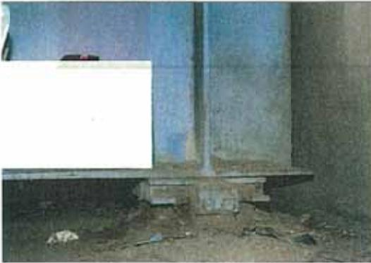
写真-11.1 支承本体の腐食
