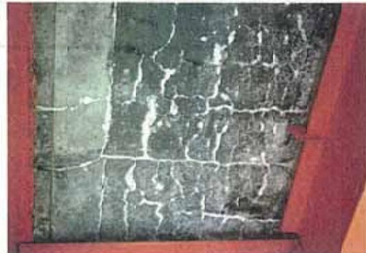
写真-8.24 格子状ひびわれ(角落ち・遊離石灰)
