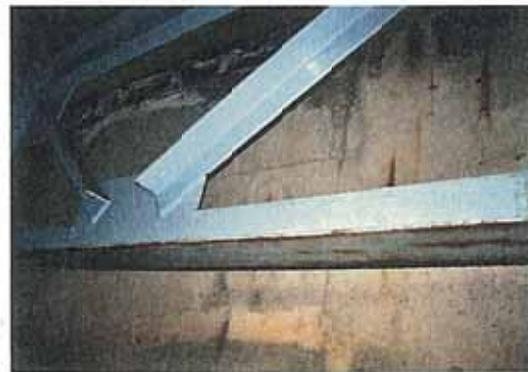
写真-1.5 端対傾構の発錆
