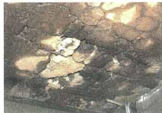
写真-8.28 格子状ひびわれ(角落ち・漏水)
