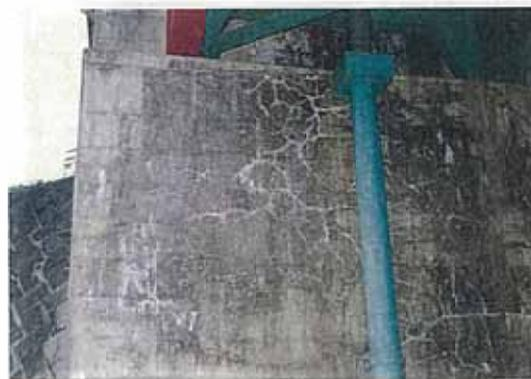
写真-5.20 橋台の幅が大きいひびわれ(②)
