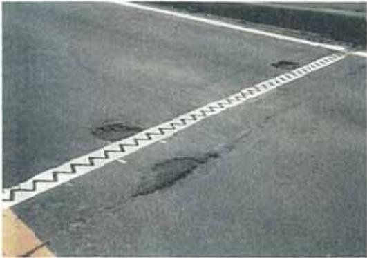
写真-10.7 伸縮継手部の段差
