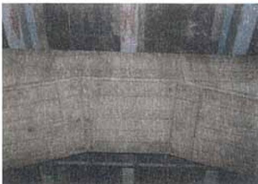
写真-5.9 橋脚の幅が大きいひびわれ(⑤)
