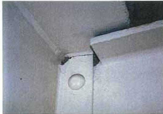
写真-2.11 垂直補剛材の亀裂
