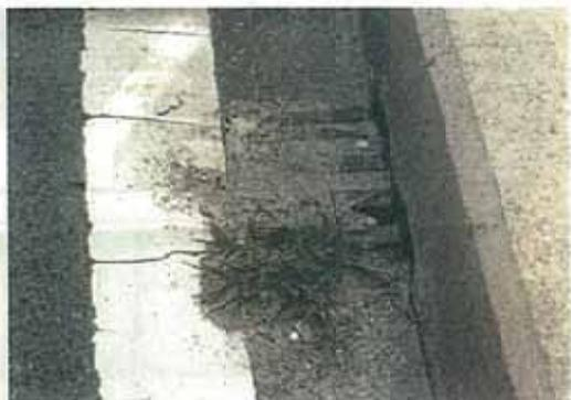
参考写真-11.1 排水溝に土砂詰りが生じた例
