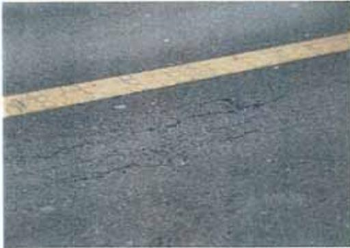
参考写真-5.1 舗装のひび割れの例
