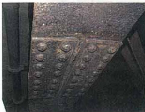
写真-1.20 主桁下フランジの発錆
