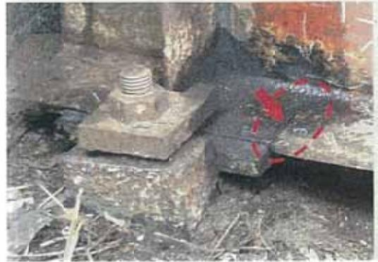
写真-2.5 主桁下フランジの亀裂
