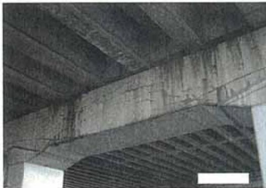
写真-5.25 橋脚の幅が大きいひびわれ(③)
