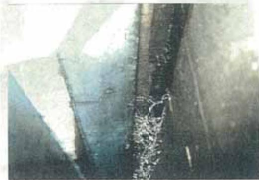
参考写真-8.1 伸縮装置から漏水が生じた例
