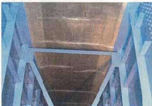
写真-8.11 一方向ひびわれ(遊離石灰)
