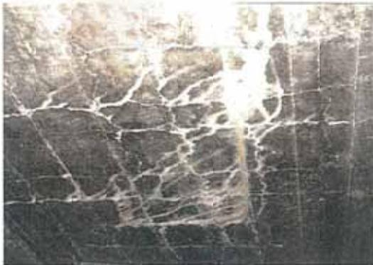
写真-8.23 格子状ひびわれ(角落ち・遊離石灰)
