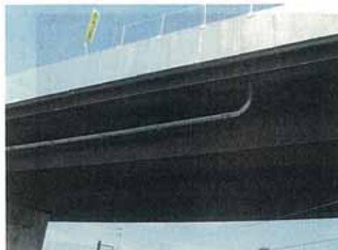
写真-1.19 耐候性鋼材の一樣な錆
