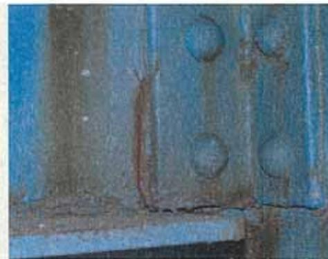
写真-2.13 横桁接合部の亀裂
