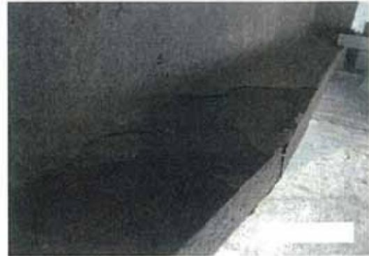
写真-1.23 主桁下フランジの層状剥離
