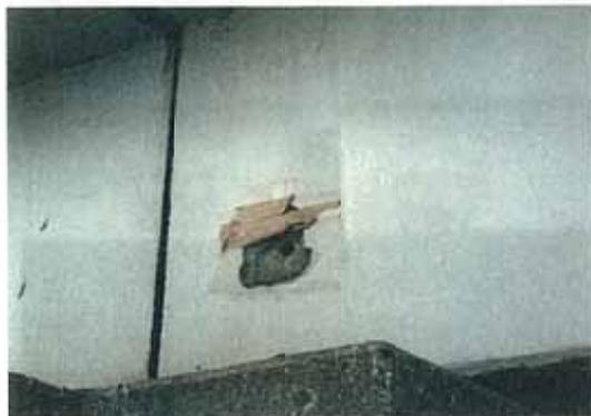
写真-9.8 PC鋼材の抜け出し
