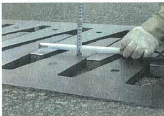
写真-10.3 伸縮継手部の段差
