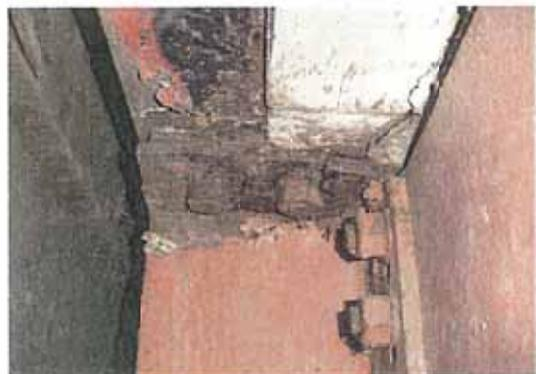
写真-2.9 主桁上フランジの亀裂
