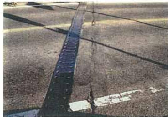
写真-10.8 伸縮継手部の段差
