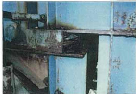
写真-11.9 支承本体の腐食
