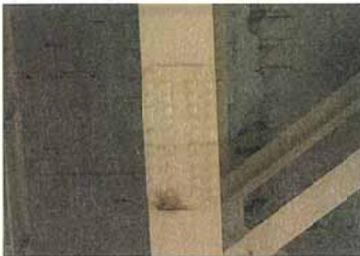
写真-3.3 主桁添接部のホルト脱落
