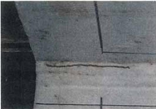
写真-2.15 鋼製橋脚隅角部の亀裂
