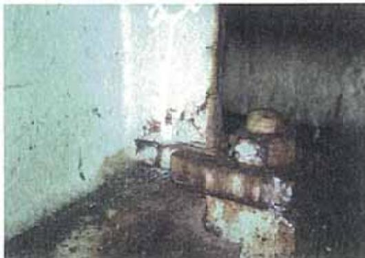
写真-2.8 垂直補剛材の亀裂
