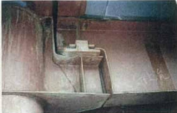
写真-4.1 ゲルバー桁掛け違い部に発生した亀裂
