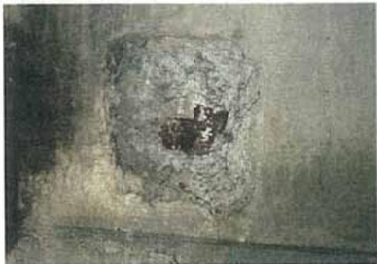
写真-9.7 定着コンクリートの剥離
