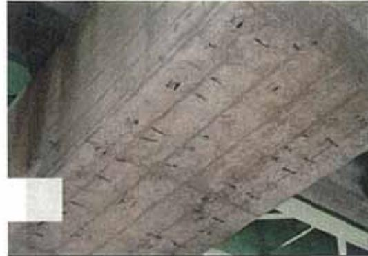
写真-6.2 主桁の鉄筋露出(表面のみ)
