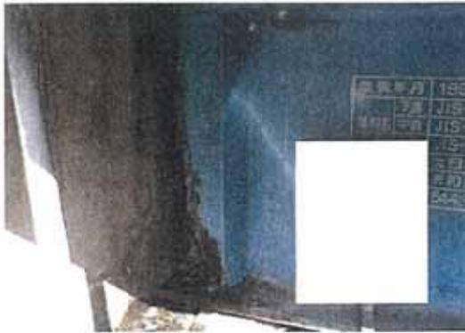
写真-1.13 主桁端部の発錆
