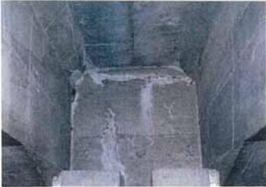
写真-5.26 端横桁の幅が大きいひびわれ
