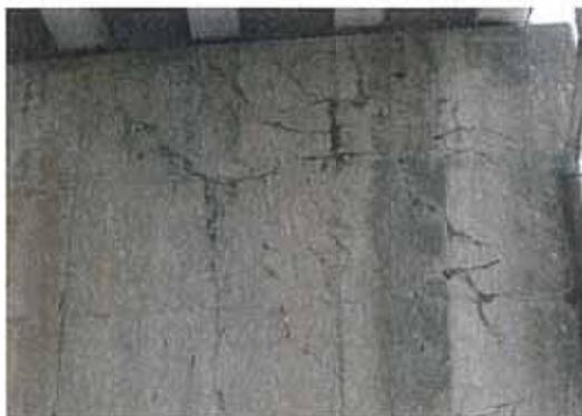
写真-5.14 橋台の幅が大きいひびわれ
