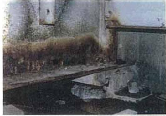
写真-1.12 主桁端部の発錆
