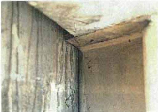
参考写真-4.1 主桁と橋台のずれが生じた例
