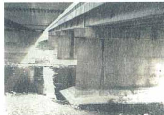
写真-12.6 基礎周辺土砂の軽微な洗掘
