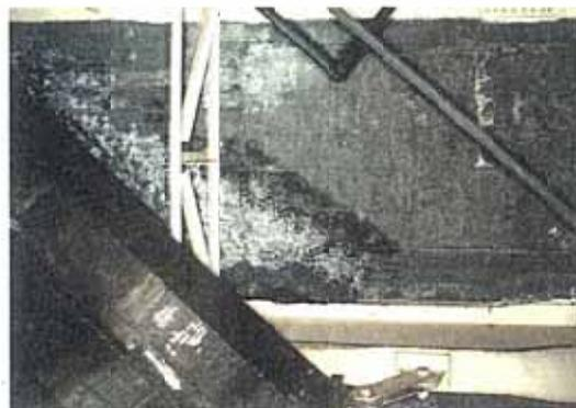
写真-8.27 格子状ひびわれ(角落ち・遊離石灰)
