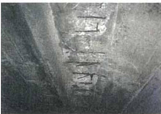
写真-6.11 床版の鉄筋露出
