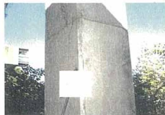
写真-5.10 橋脚の幅が大きいひびわれ(⑥)
