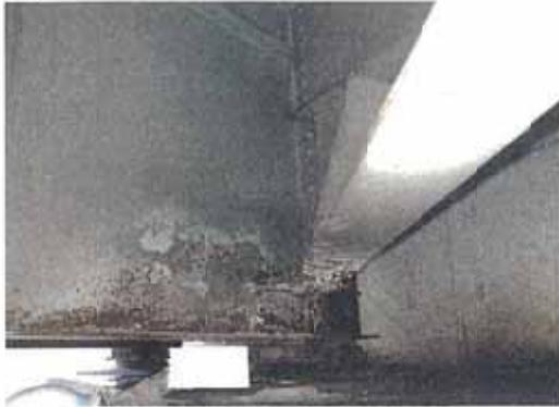
写真-1.11 主桁端部の発錆
