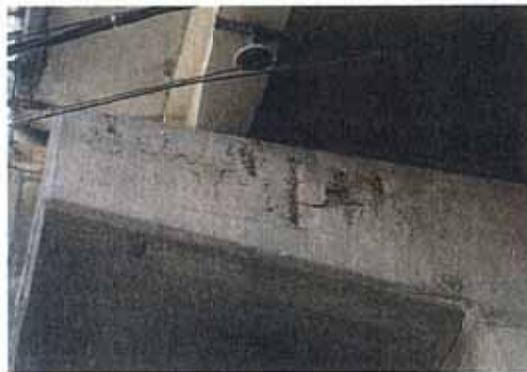
写真-6.8 橋脚の鉄筋露出(部分的)
