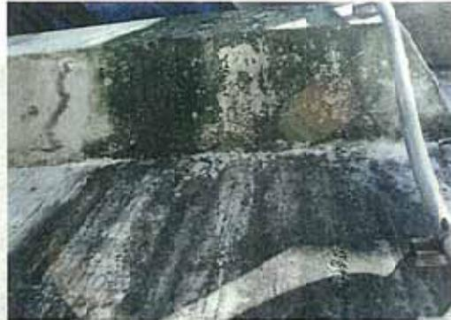
参考写真-6.3 コンクリート部材の表面を伝う水による汚れの例
