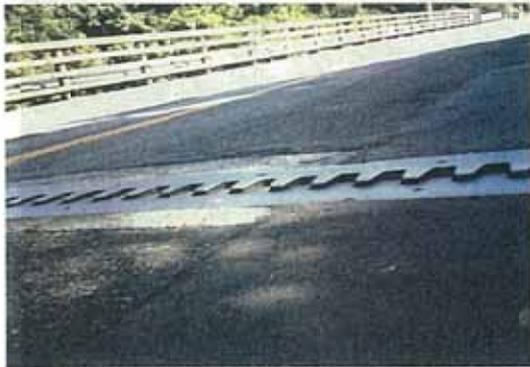
写真-10.11 伸縮継手部の段差
