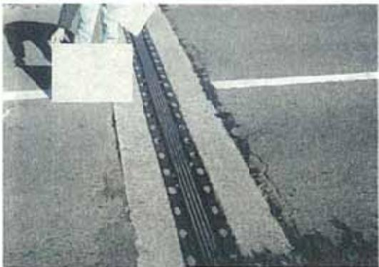
写真-10.9 伸縮継手部の段差
