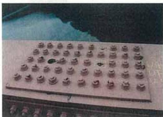
写真-3.11 弦材添接部のホール脱落
