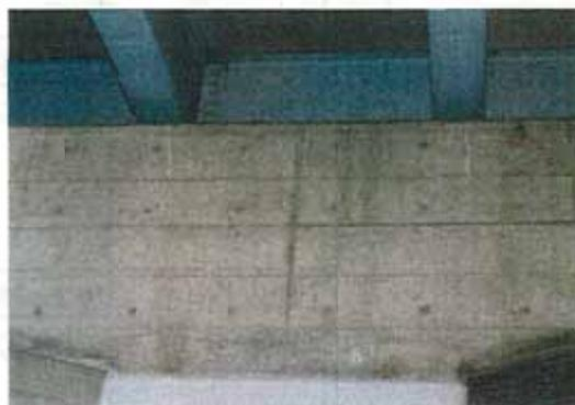
写真-5.2 橋脚の幅が小さいひびわれ
