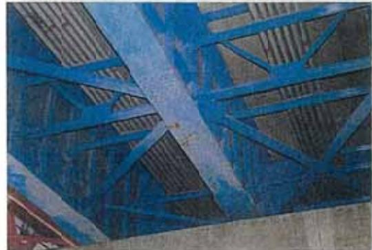
写真-1.3 主桁下フランジの発錆
