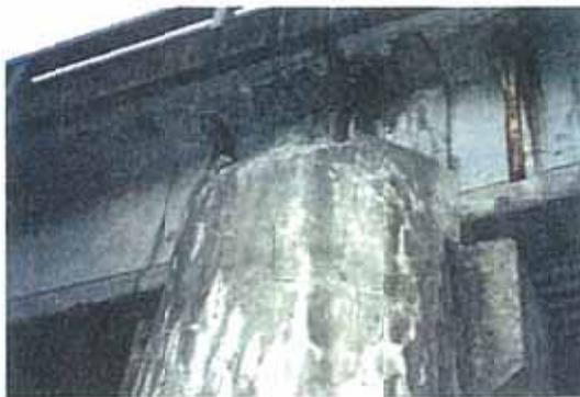
写真-5.30 橋脚の幅が大きいひびわれ(②)
