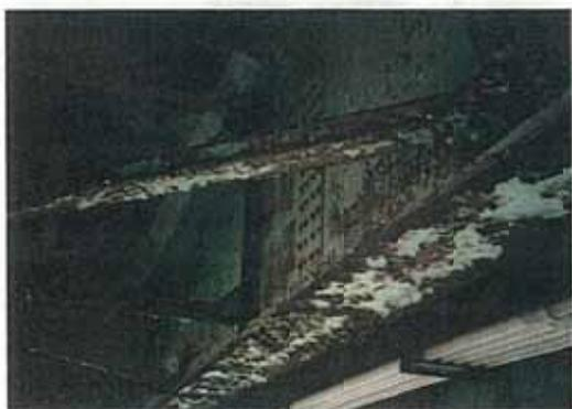
写真-1.17 主桁の発錆
