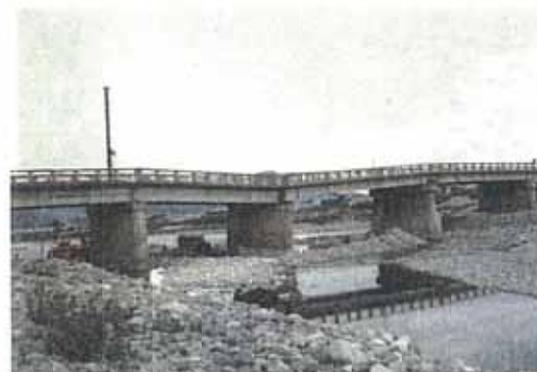
写真-12.10 下部工の沈下・傾斜
