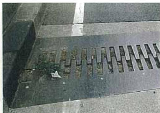
参考写真-11.3 伸縮装置の遊目にも土砂詰りが生じた例
