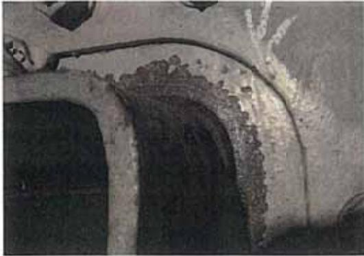
写真-2.10 主桁切欠部の亀裂
