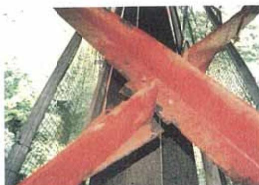
写真-4.5 横構の破断
