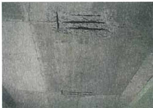
写真-6.4 床版の鉄筋露出(部分的)
