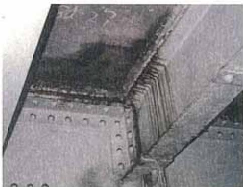
写真-1.6 縦桁・横桁の発錆
