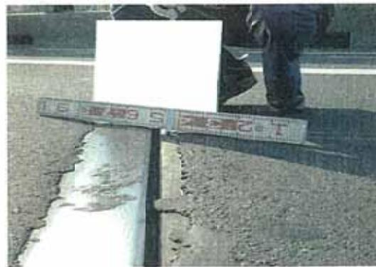
写真-10.4 伸縮継手部の段差
