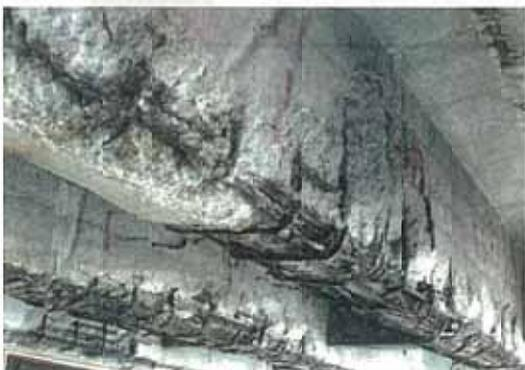
写真-6.9 主桁の鉄筋露出
