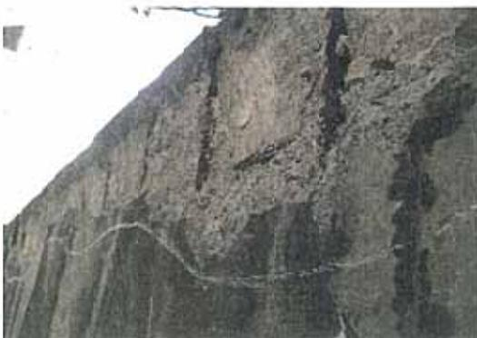
写真-6.13 下部工の鉄筋露出
