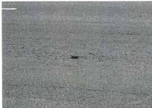
参考写真-5.3 舗装にひび割れとポットホールが生じた例
