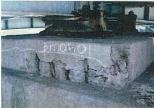
写真-11.6 台座部の破損
