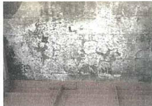
写真-8.26 格子状ひびわれ(角落ち・遊離石灰)
