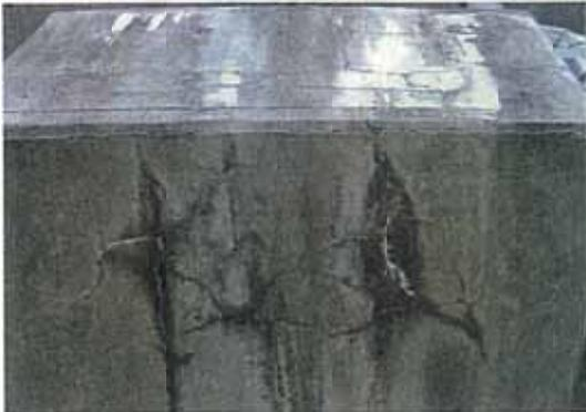
写真-5.23 橋脚の幅が大きいひびわれ(②)
