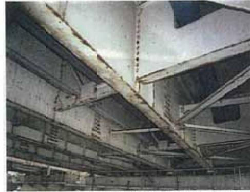
写真-1.9 主桁・対傾構・横構の発錆
