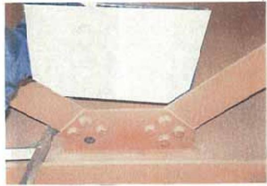
写真-3.9 横構のホルト脱落
