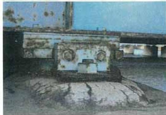
写真-11.7 台座部の破損
