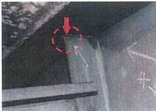
写真-2.3 垂直補剛材の長さが短い亀裂
