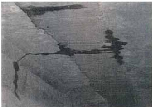
写真-5.12 主桁間詰部の幅が大きいひびわれ
