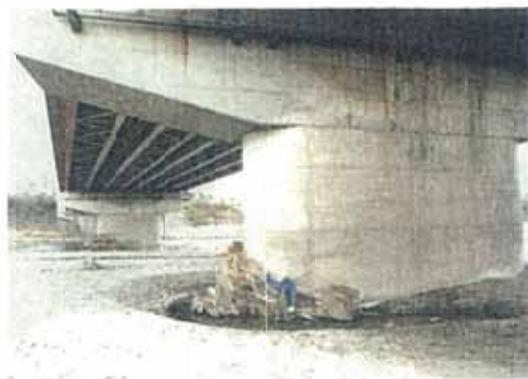
写真-12.9 基礎周辺土砂の著しい洗掘
