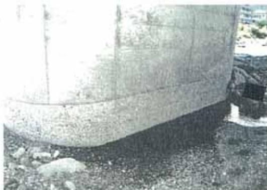
写真-12.5 基礎周辺土砂の軽微な洗掘
