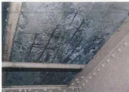
写真-6.10 床版の鉄筋露出
