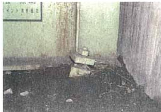
写真-11.19 支承の傾斜・土砂堆積
