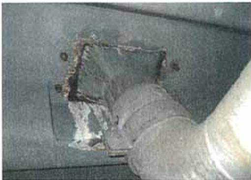
参考写真-8.3 箱行内部の排水枮からの漏水により、箱行内部に滞水と鋼材の腐食が生じた例
