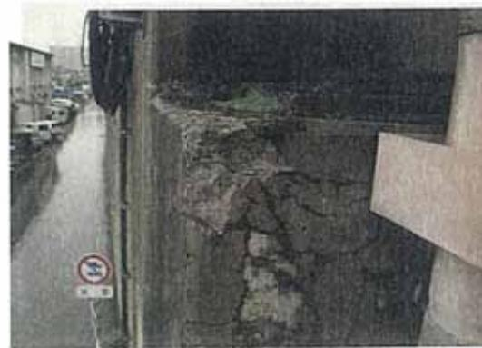
写真-5.22 橋台の幅が大きいひびわれ(②)
