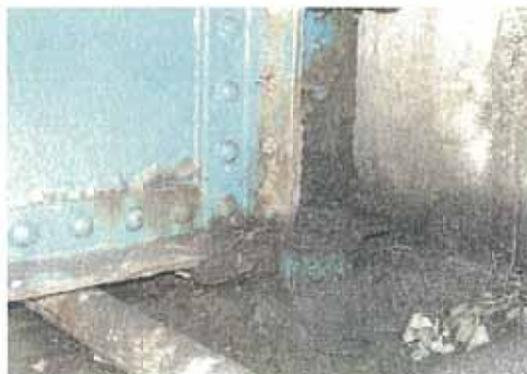
写真-11.18 本体の腐食・土砂堆積
