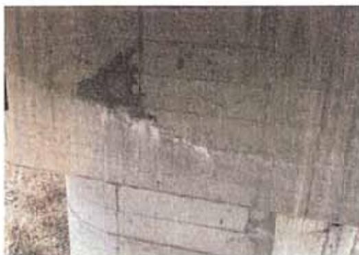
写真-5.16 橋脚の幅が大きいひびわれ
