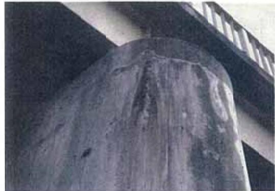
写真-5.27 橋脚の幅が大きいひびわれ
