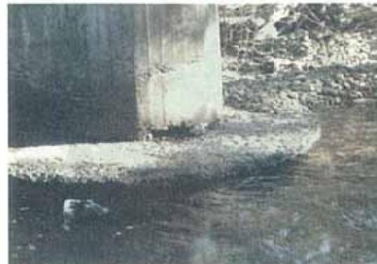
写真-12.2 下部工基礎部の軽微な洗掘
