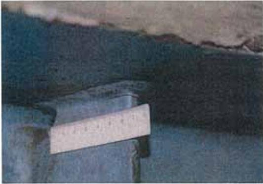
写真-2.1 垂直補剛材の塗膜割れ
