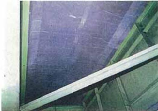
写真-8.2 幅の小さい、一方向ひびわれ
