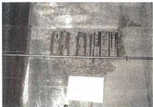
写真-6.7 下部工の鉄筋露出(部分的)
