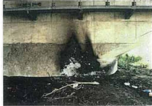
参考写真-6.2 火災による変色の例
