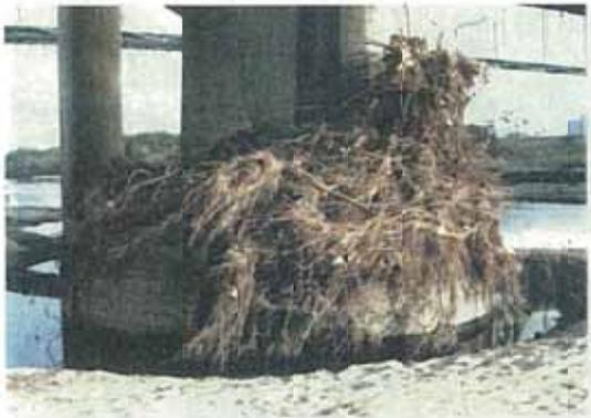
写真-12.7 基礎周辺土砂の著しい洗掘
