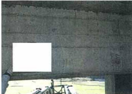
写真-5.5 主桁の幅が大きいひびわれ(③)
