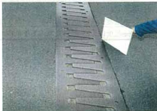
写真-10.2 伸縮継手部の段差
