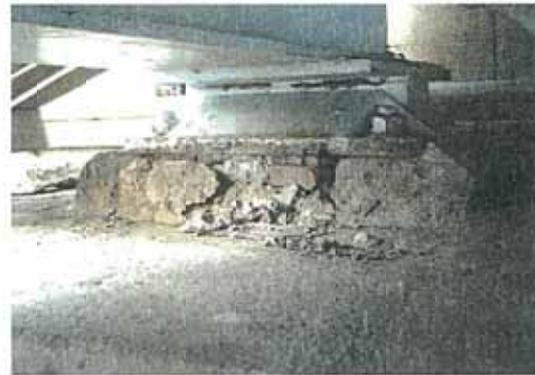
写真-11.17 台座部の破損
