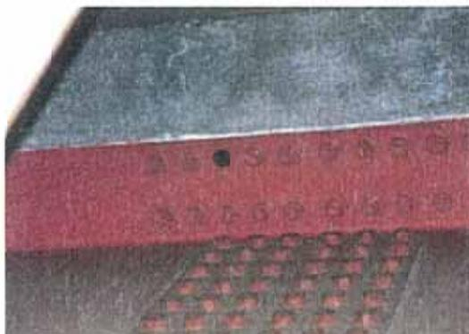
写真-3.5 主桁添接部のホルト脱落
