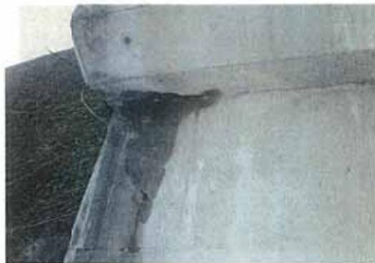
写真-5.13 橋台の幅が大きいひびわれ
