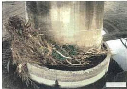
写真-12.8 基礎周辺土砂の著しい洗掘
