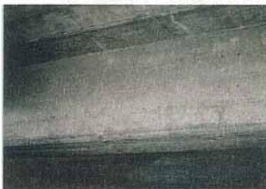
写真-5.3 主桁の幅が大きいひびわれ
