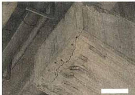
写真-5.7 橋脚の幅が大きいひびわれ(②)
