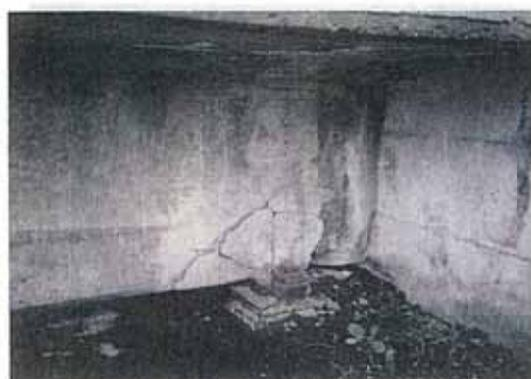
写真-5.19 主桁の幅が大きいひびわれ(⑤)
