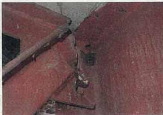
写真-4.3 対傾構取付部の破断
