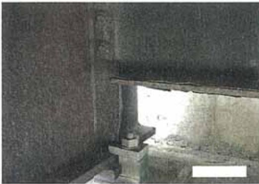
写真-1.24 端横桁の層状剥離
