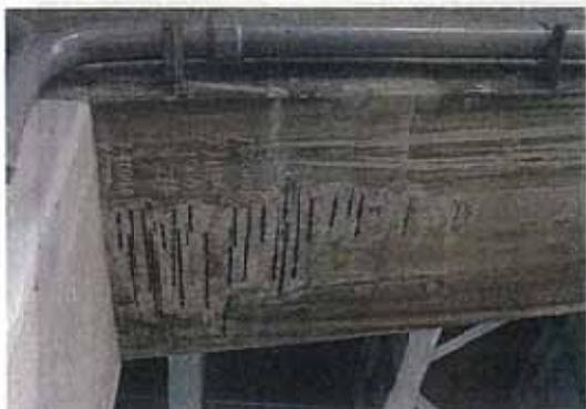
写真-6.6 橋脚の鉄筋露出(表面のみ)
