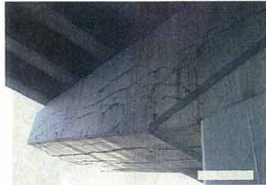
写真-5.24 橋脚の幅が大きいひびわれ(③)
