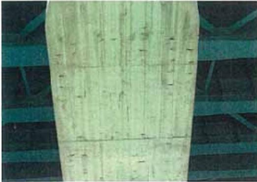
写真-6.1 主桁の鉄筋露出(表面のみ)
