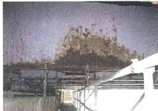
写真-1.14 主桁ウェブ・下フランジの発錆
