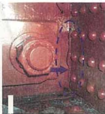
写真-2.14 桁連結装置の亀裂
