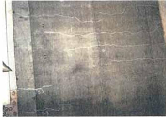
写真-8.5 幅の小さい、一方向ひびわれ
