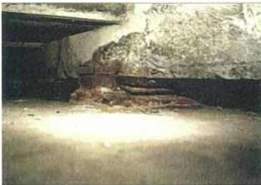
写真-11.10 支承本体の腐食
