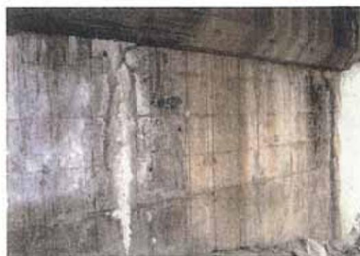
写真-5.15 橋台の幅が大きいひびわれ
