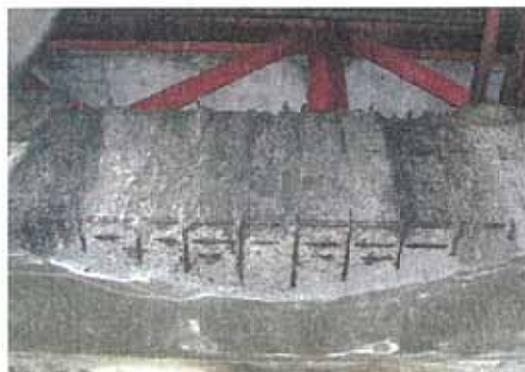
写真-6.14 下部工の鉄筋露出
