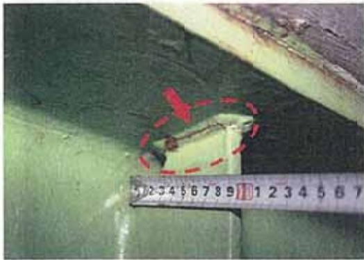
写真-2.12 垂直補剛材の亀裂
