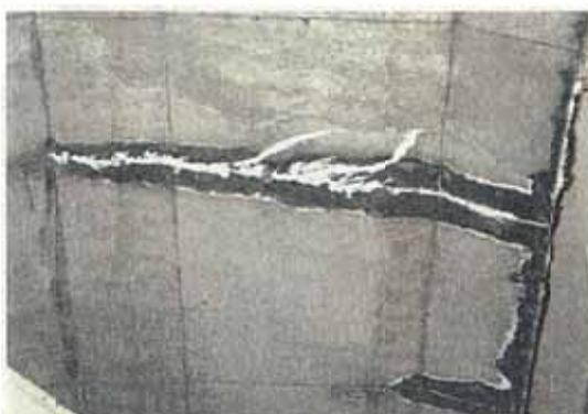
写真-8.13 一方向ひびわれ(遊離石灰)
