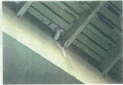
参考写真-8.2 排水枮から漏水が生じた例
