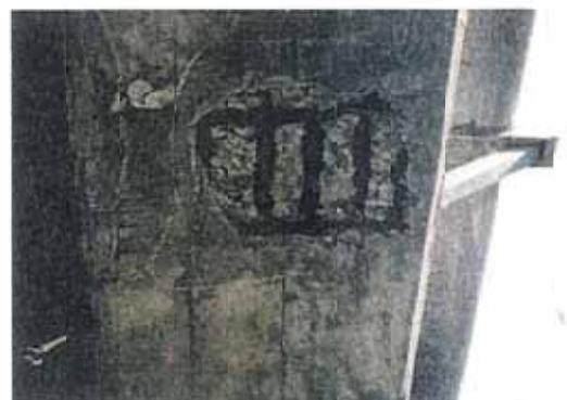
写真-6.5 主桁の鉄筋露出(部分的)
