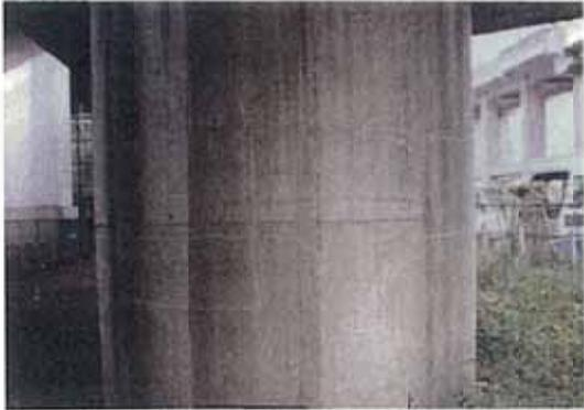
写真-5.11 橋脚の幅が大きいひびわれ(⑥)
