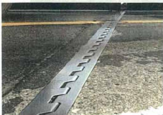
写真-10.1 伸縮継手部の段差
