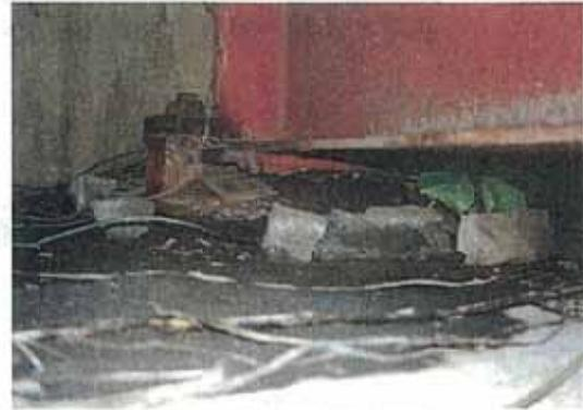
写真-11.15 台座部の破損
