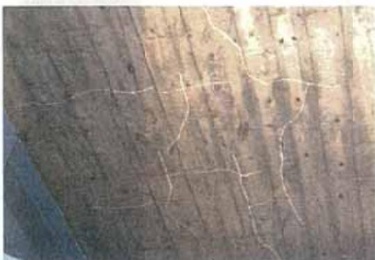
写真-8.1 幅が小さく、間隔が1.0m程度のひびわれ
