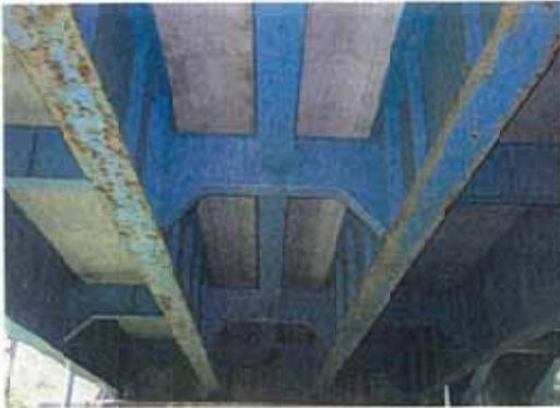
写真-1.8 主桁下フランジの発錆
