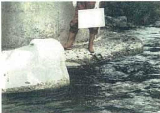
写真-12.1 下部工基礎部の軽微な洗掘
