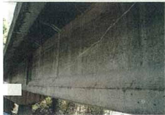
写真-5.6 主桁の幅が大きいひびわれ(④)
