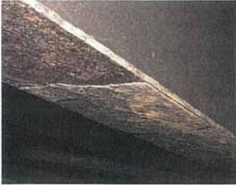
写真-1.22 主桁下フランジの層状剥離
