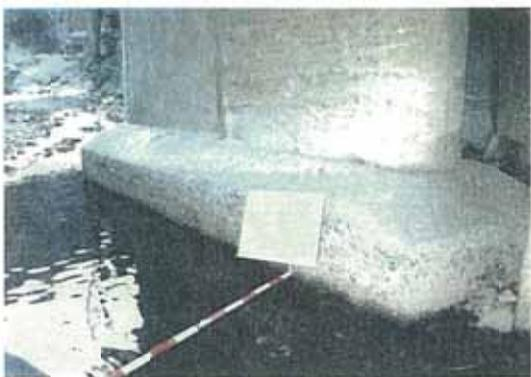
写真-12.3 下部工基礎部の軽微な洗掘
