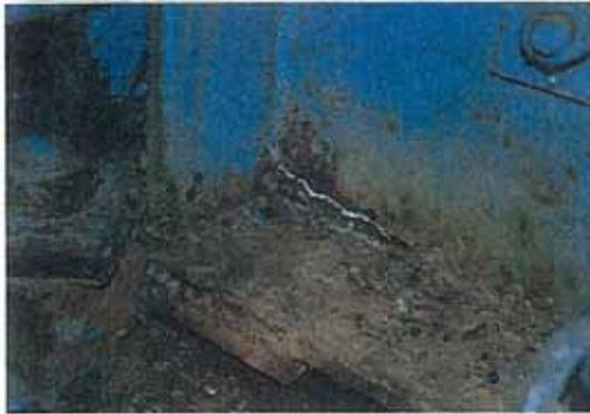
写真-2.4 主桁ウェブの亀裂
