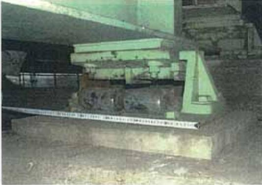
写真-11.8 支承本体の破損
