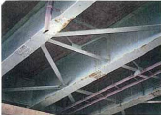
写真-1.2 主桁下フランジの発錆
