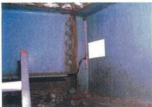
写真-4.2 垂直補剛材の破断
