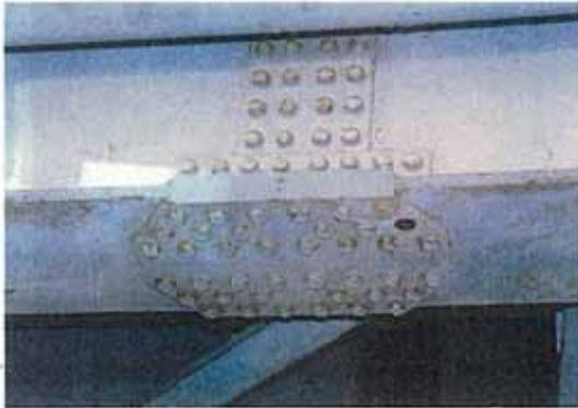
写真-3.1 主桁添接部のホルト脱落
