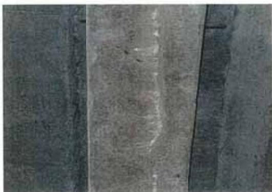
写真-5.17 主桁の幅が大きいひびわれ(②)
