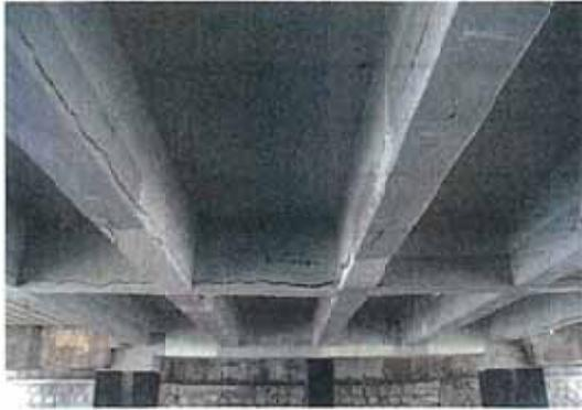
写真-5.28 主桁の幅が大きいひびわれ(⑧)
