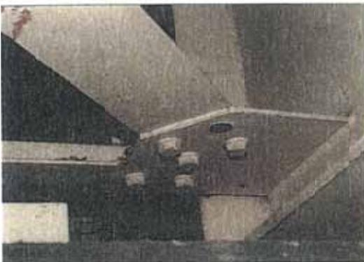
写真-3.10 横構のホルト脱落
