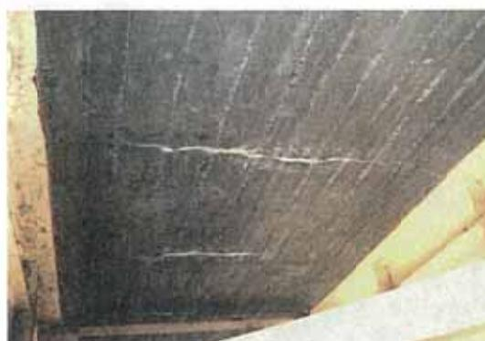
写真-8.12 一方向ひびわれ(遊離石灰)
