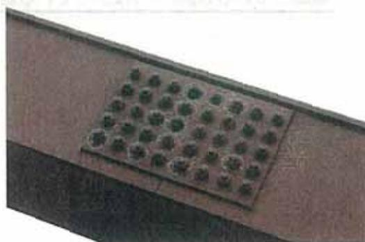
写真-3.12 弦材添接部のホール脱落
