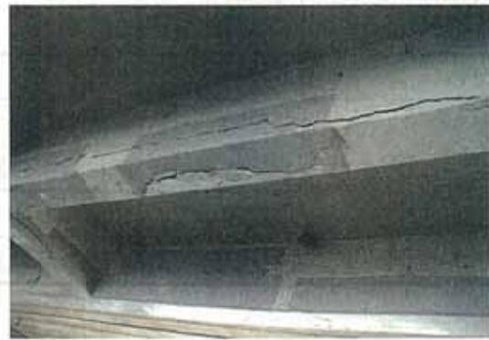
写真-5.29 主桁の幅が大きいひびわれ(⑧)
