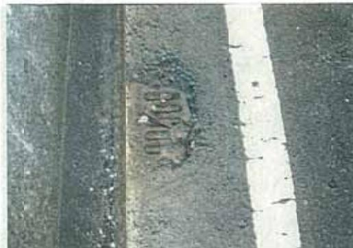
参考写真-11.2 排水溝に土砂詰りが生じた例
