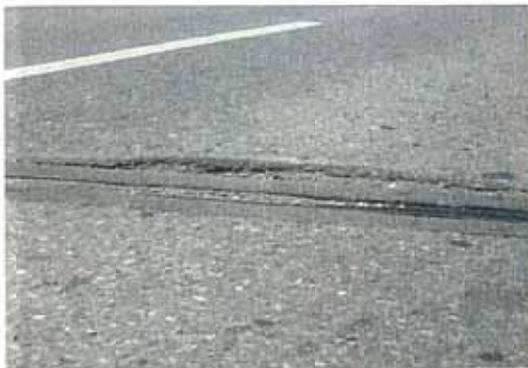
写真-10.13 伸縮継手部の段差
