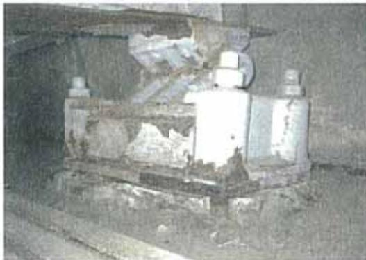
写真-11.16 台座部の破損
