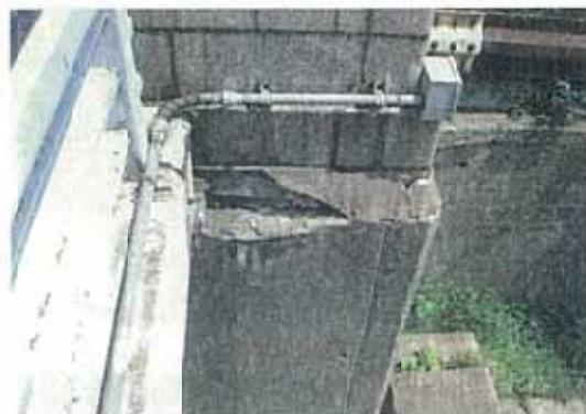
写真-12.11 下部工の傾斜
