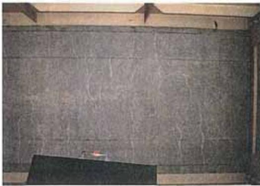
写真-8.4 幅の小さい、一方向ひびわれ
