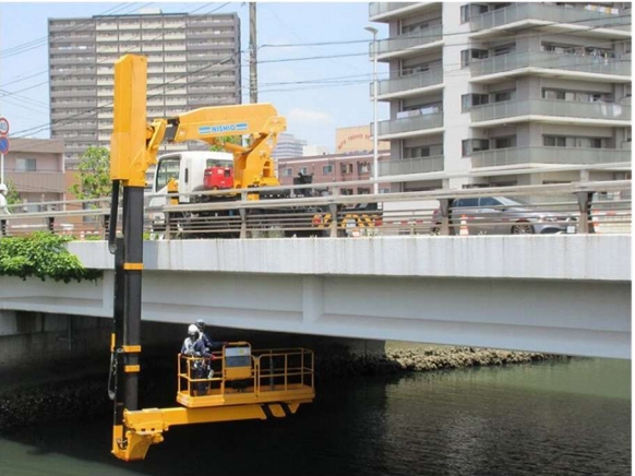
写真1 定期点検（近接目視）
