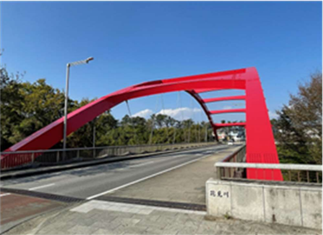
写真4 塗装塗替（施工後）
