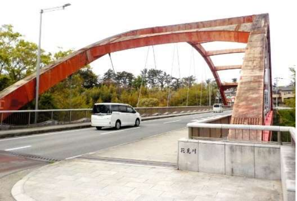
写真3 塗装塗替（施工前）
