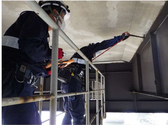
写真2 定期点検（近接目視）
