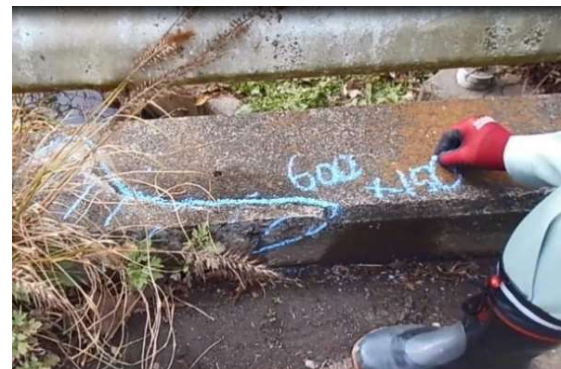
写真8 職員点検状況④
