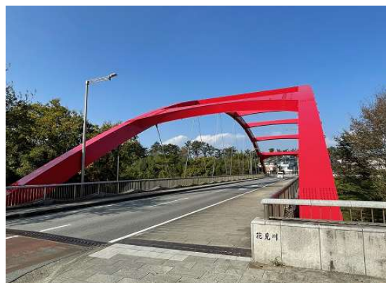
写真 12 塗装塗替 施工後
