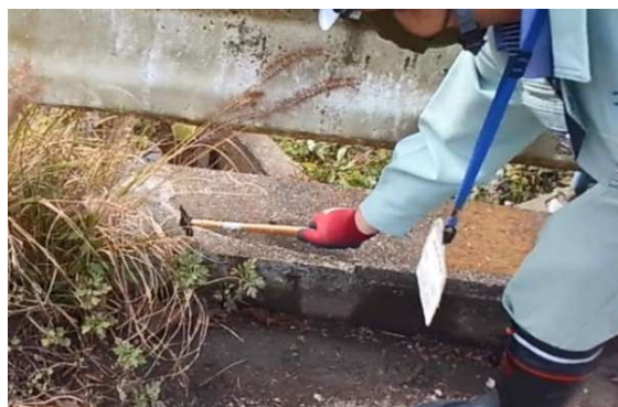
写真7 職員点検状況③
