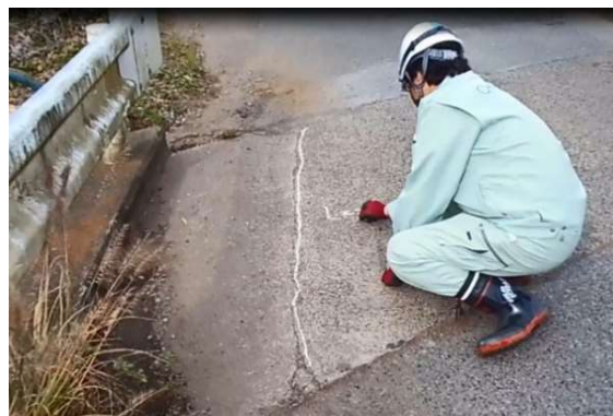
写真6 職員点検状況②
