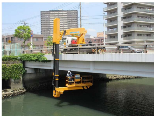
写真1 橋梁定期点検状況①
