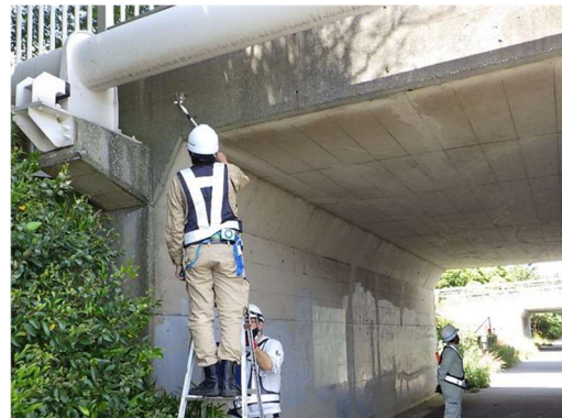
写真4 橋梁定期点検状況④
