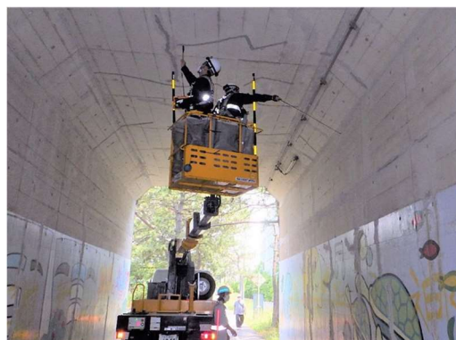
写真2 橋梁定期点検状況②
