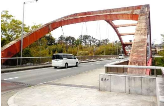
写真 11 塗装塗替 施工前
