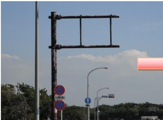
※横梁に腐食が確認され標識板を一時撤去
