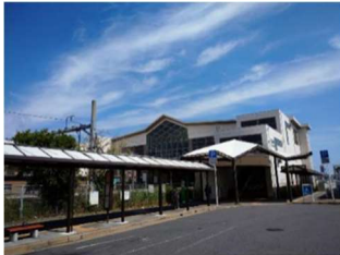
写真1 浜野駅自由通路
