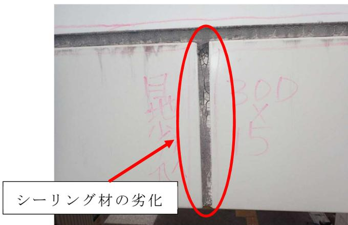
写真5 損傷写真5
