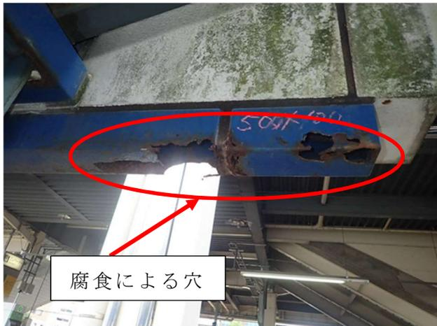
写真7 部分損傷写真1
