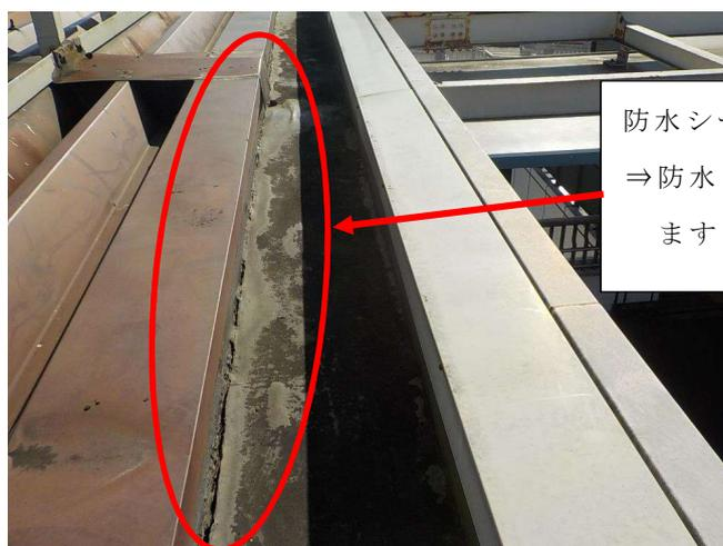
防水シートが劣化損傷し雨水の侵入が想定される
