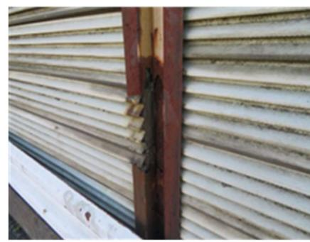
図9 支柱の劣化
