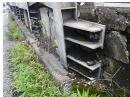
図8 車両衝突による基部破損
