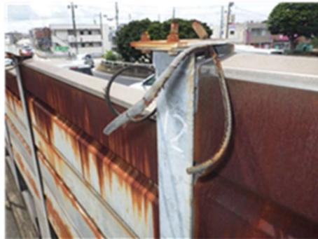
図7 落下防止ワイヤーの破断
