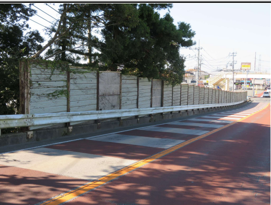
写真 9 千葉大網線（誉田跨線橋）
