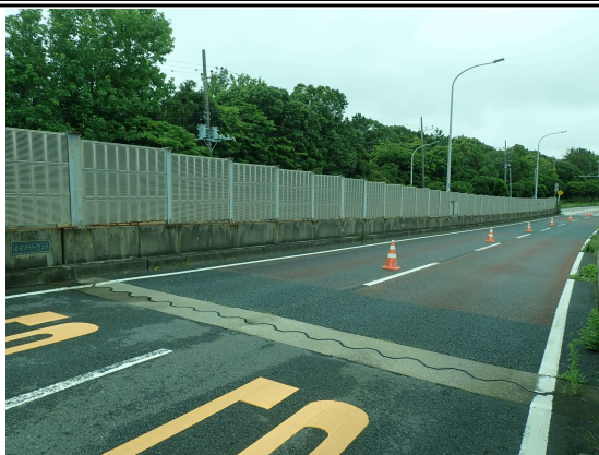
写真 5 中瀬幕張本郷線(浜田陸橋)
