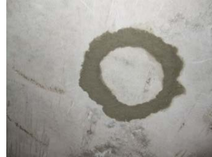
⑨断面修復材充填完了
