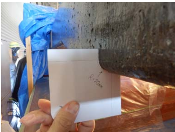
(a) 角部面取り状況
