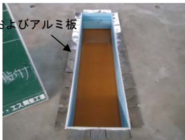
③発泡型枠の設置
