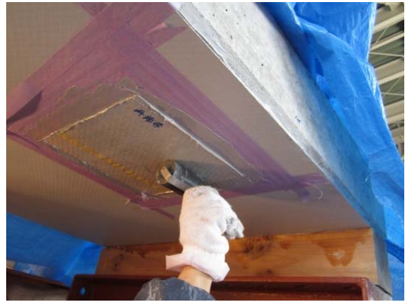
(b) 切り欠き部に対する施工(補修)
