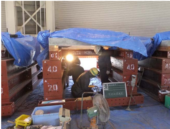
(a) 施工状況 (架台設置)
