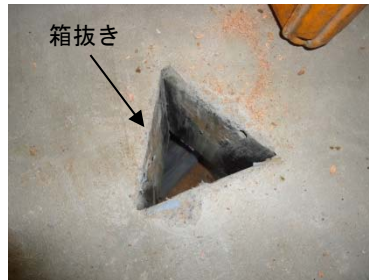
②箱抜き型枠の撤去
