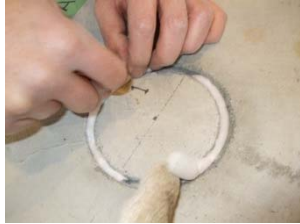
④離隔調整材 (φ13mm) 上面側より2重目設置
