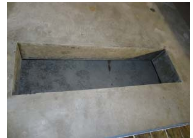
②箱抜き型枠の撤去
