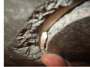
⑥離隔調整材設置位置調整
