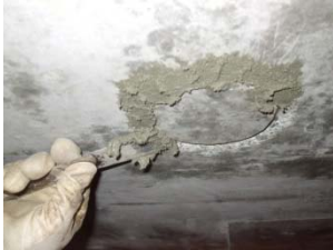
⑧断面修復材充填 左官作業
