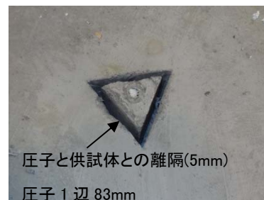
⑤発泡型枠の撤去
