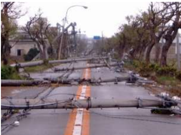
台風14号による電柱の倒壊 (出典) 国土交通省ホームページ
