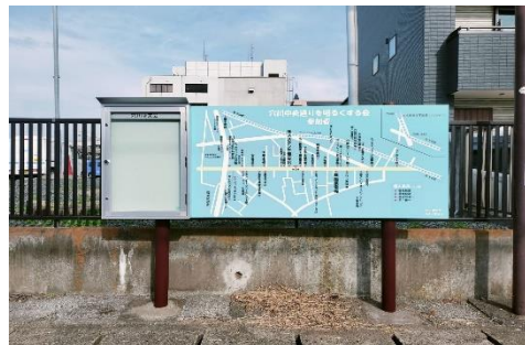
▼商店街看板修繕
