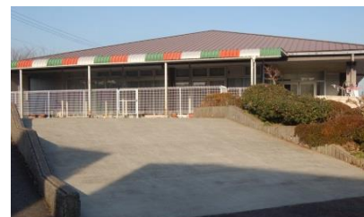
▼スロープ修繕
