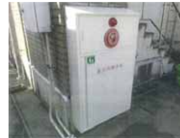
千葉競輪場・サイクル会館改修工事 サイクル会館 スプリンクラー設備 組立敷水栓 交換後
