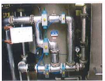
写真No.4 撮影日 2015年8月25日(火) 設置箇所 3階ろ過機械室 対象物 ろ過器本体用自動弁・配管 写真説明 施工後
