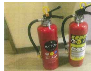
千葉競輪場・サイクル会館改修工事 サイクル会館 消火器具 粉末ABC消火器10型 交換中
