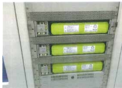
千葉競輪場・サイクル会館改修工事 千葉競輪場 メインスタンド 非常警報器具 防炎センター内 予備バッテリー 交換後
