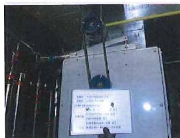
写真No.4 撮影日 2015/9/25・26 設置箇所 空調機械室 対象物 外調機 写真説明 施工完了 モーターベアリング交換 Vベルト交換
