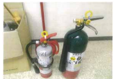
千葉競輪場・サイクル会館改修工事 千葉競輪場 メインスタンド 4階TV室 交換中
