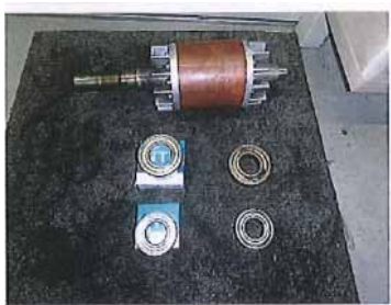
写真No.2 撮影日 2015/9/25・26 設置箇所 空調機械室 対象物 外調機 写真説明 モーターベアリング交換 左 新部品 右 旧部品
