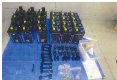
千葉競輪場・サイクル会館改修工事 千葉競輪場 メインスタンド 非常電源 HS400E×2台 12セル 撤去品
