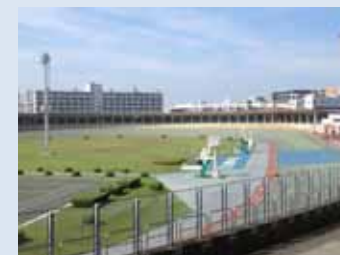
バンク走路面 経年劣化
