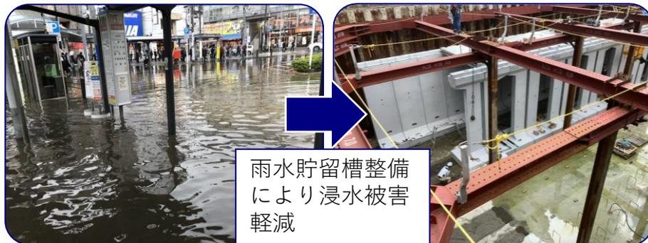
雨水貯留槽整備により浸水被害軽減
