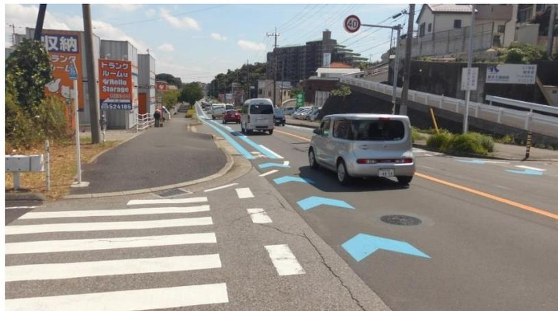
交差点部の矢羽根を2 m間隔、自転車通行帯のブルーラインを2本設置している
