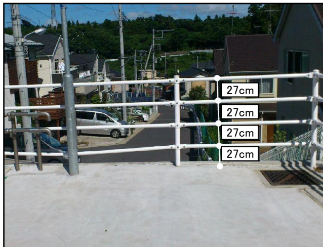
転落防止柵の状況
