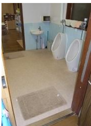
トイレの改修が行われたケース
