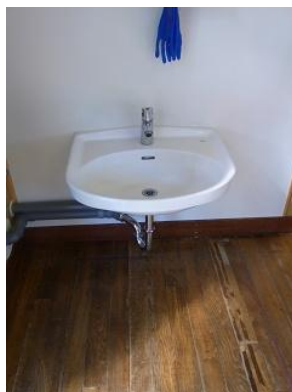
保育室に新たに手洗い場を設置したケース
