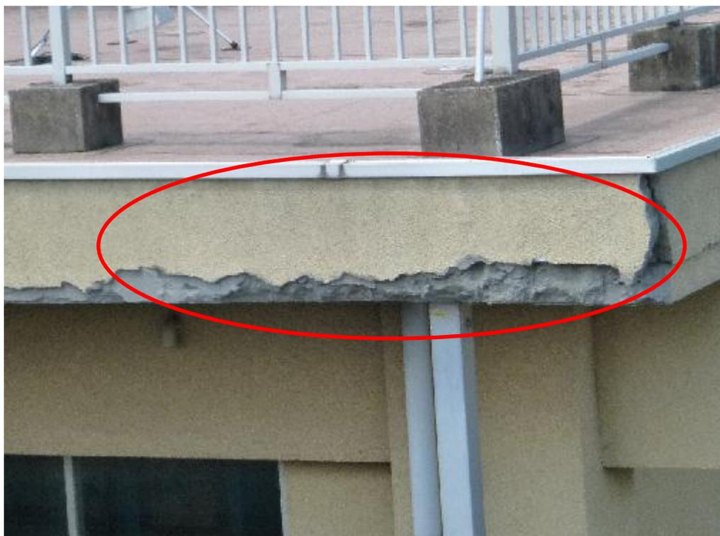
（川戸小学校校舎底部分の外壁欠落写真。鉄筋の腐食を防ぐため、応急的な措置による補修を行っている。平成 24 年 8 月 7 日包括外部監査人補助者が撮影。）
