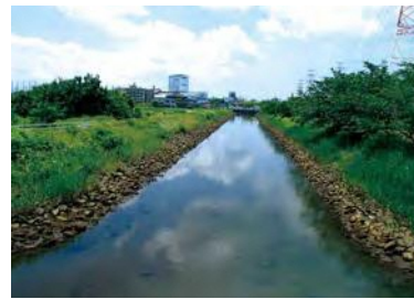
生実川(平成橋付近)
