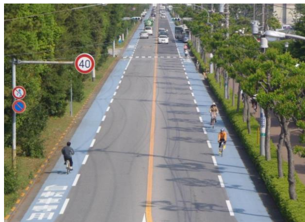
図表 1-5-13 市内の自転車レーン（市道 高洲中央港線（京葉線通り）
