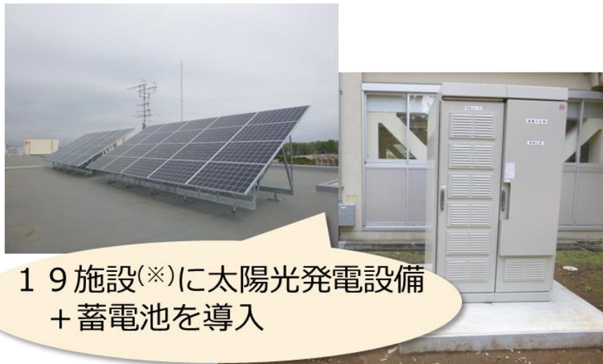
図1 避難所における太陽光発電設備・蓄電池の導入例（写真は柏台小学校の例）
