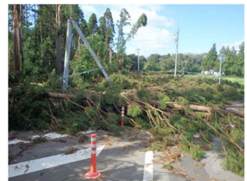
令和元年房総半島台風による被害 出典：千葉市ホームページ
