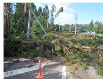
令和元年房総半島台風による被害
