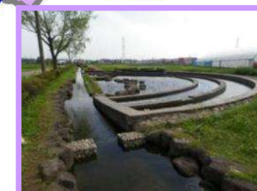
8.水環境施設(杉山地区)
