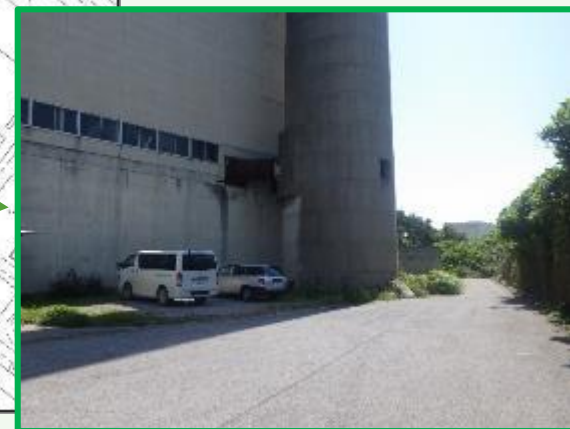
▼地下水調査地点
