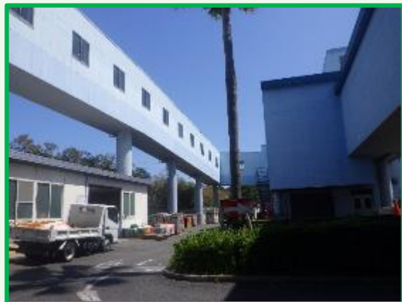
▲環境騒音・振動調査地点
