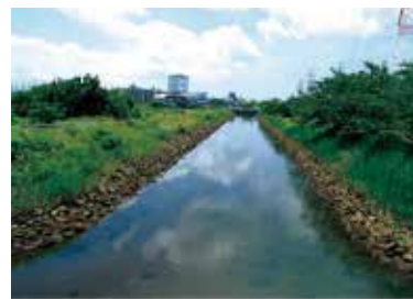
生実川(平成橋付近)
