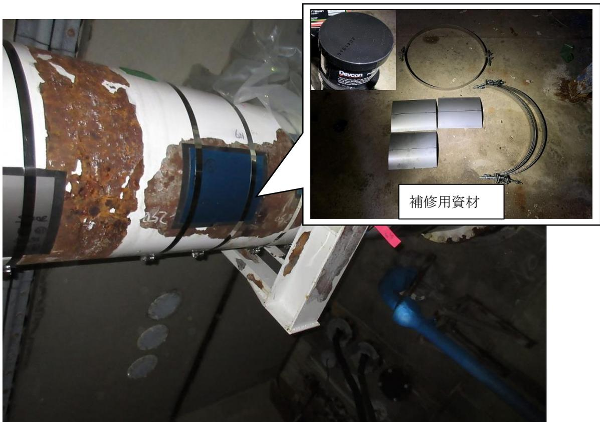
写真 2 : 応急補修後
