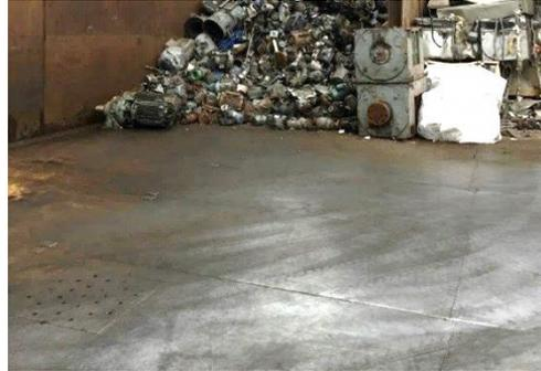
(左：ヤード床面はコンクリート（350mm）で舗装。写真は工事中のもの)
