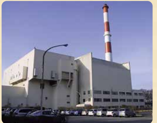
北谷津清掃工場(若葉区北谷津町)
